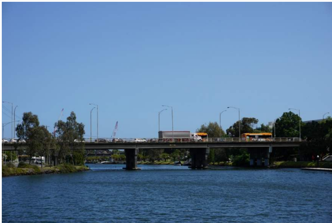
Dynon Road (Hopetoun) bridge
